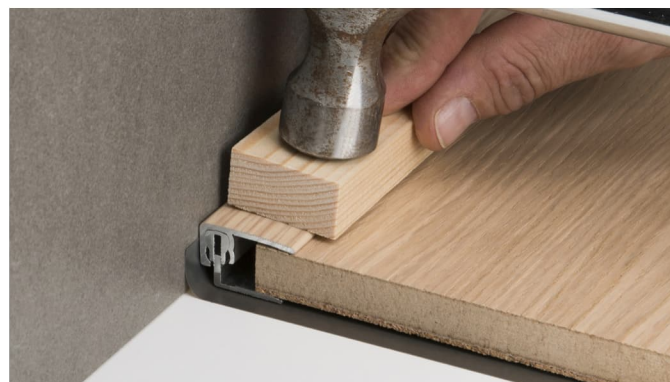
Instalace ukončovacího profilu hliníkového
