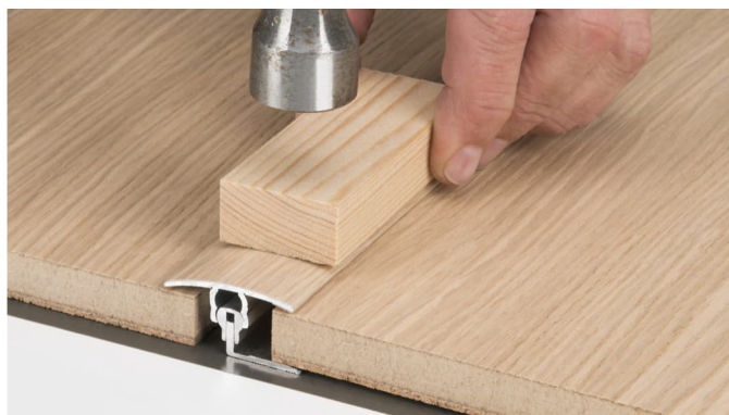
Instalace přechodového profilu hliníkového
